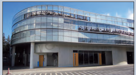
施工例 施工場所：東京都調布市 用途：学校 構造：RC造 竣工：2012年1月
